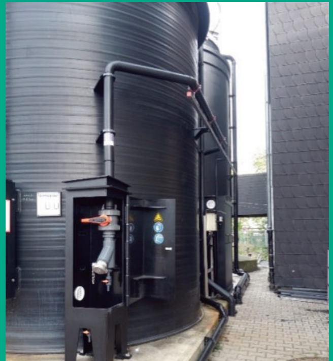
Befüllstutzenschrank
