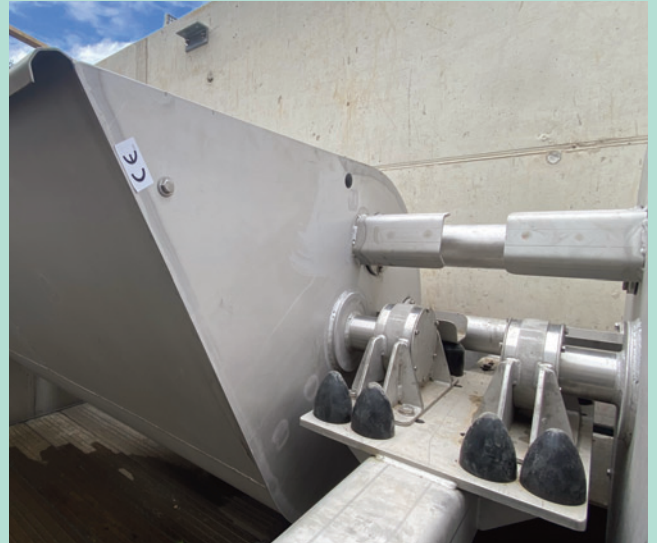
Doppelaufleger der Spülkippentröge mit Gummipuffern zur Abdämpfung der Stoßkräfte
