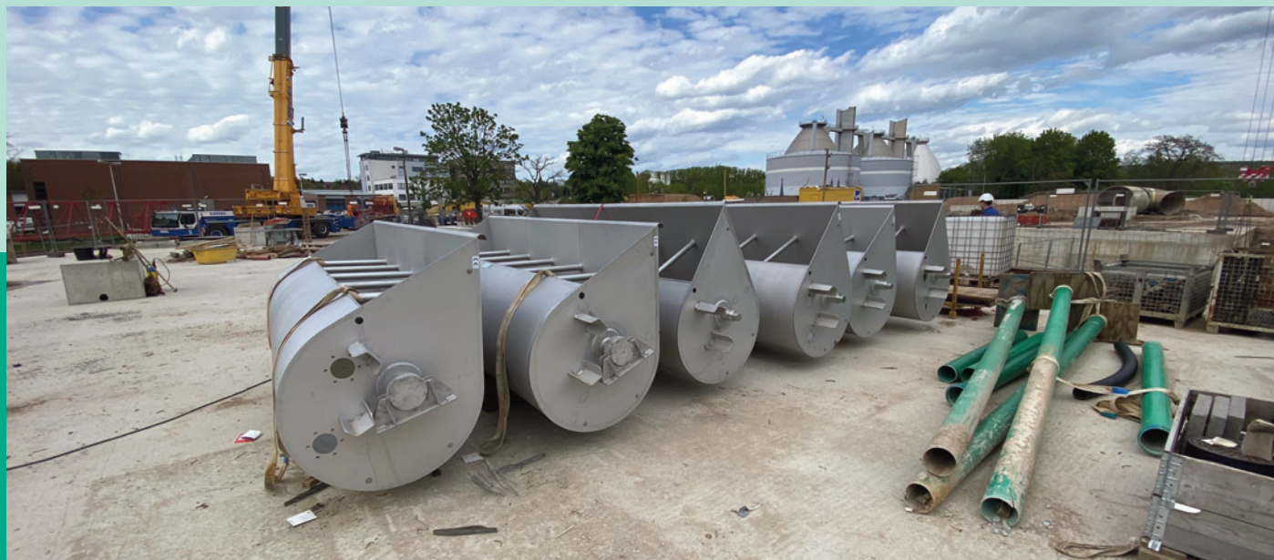
Angelieferte Steinhardt HydroSelf® Spülkippen auf dem Werksgelände der Kläranlage in Kassel
