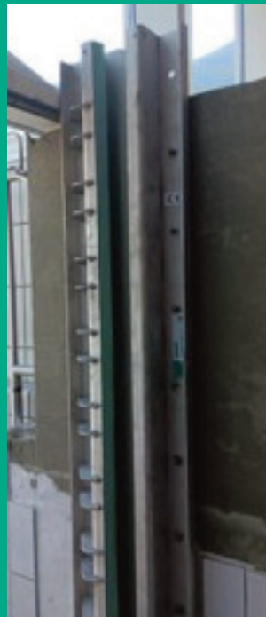
Montage der Dammbalkenrahmen
