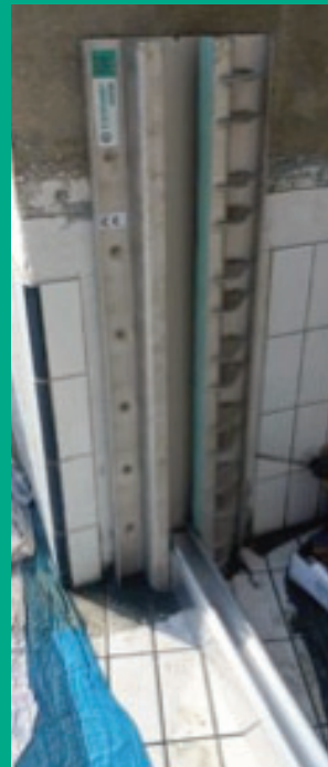
Nach durchgeführter Montage - Rahmen HydroBeam Dammbalkensystem
